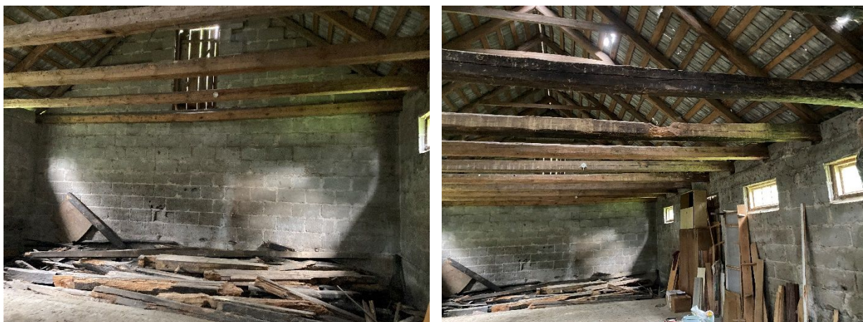
Widok szczegółów pomieszczenia
