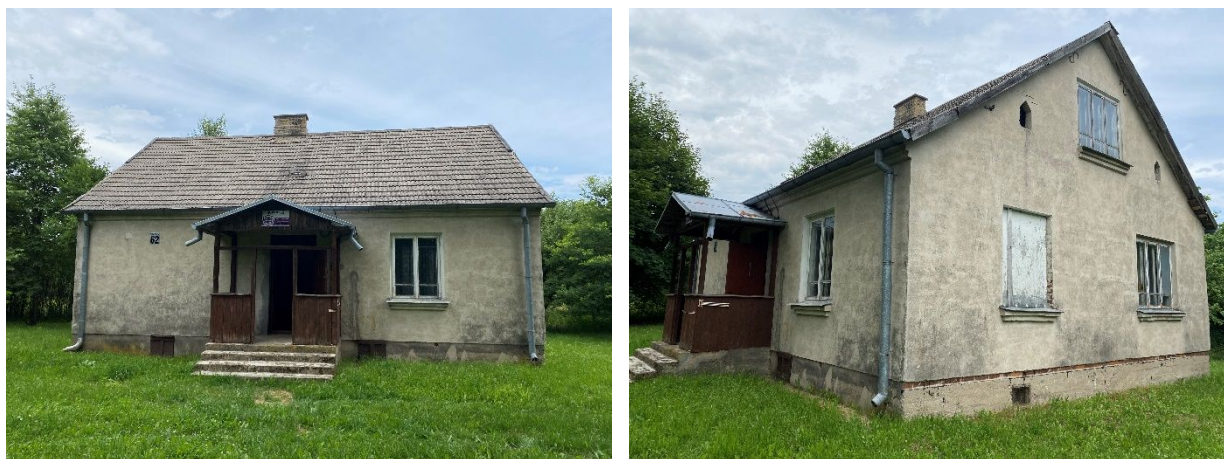
Widok ogólny budynku, elewacja frontowa i boczna
