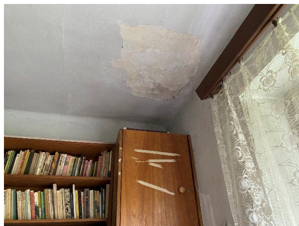
Widok ubytków tynku
