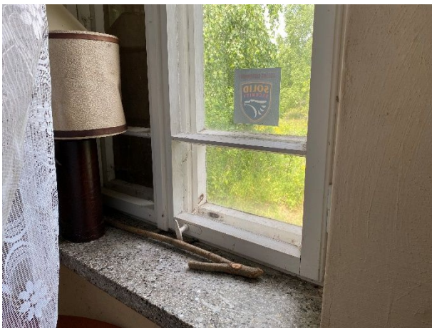
Widok szczegółów stolarki
