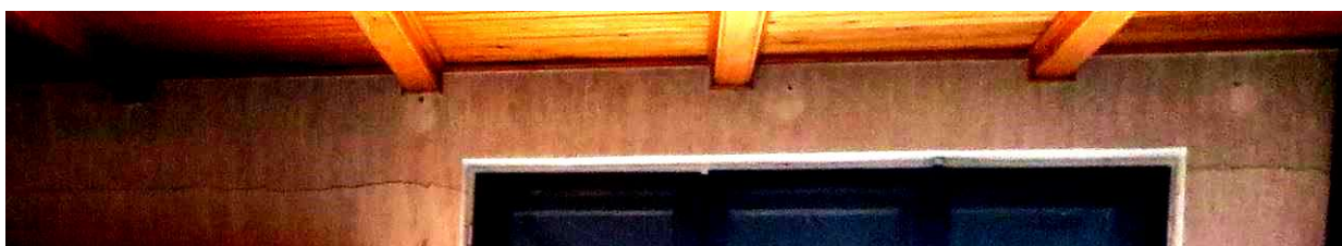
/pęknięcie ściany zewnętrznej tylnej budynku widoczne wewnątrz pokoi I-piętra przy suficie/
