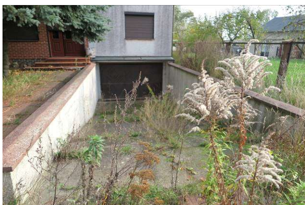
/wjazd do garażu budynku/
