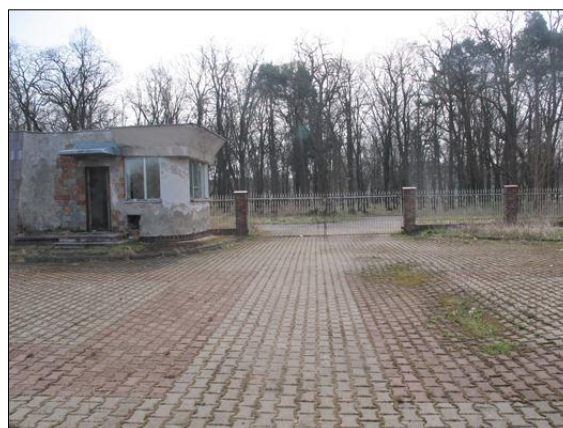
Brama wjazdowa – widok od strony północnej
