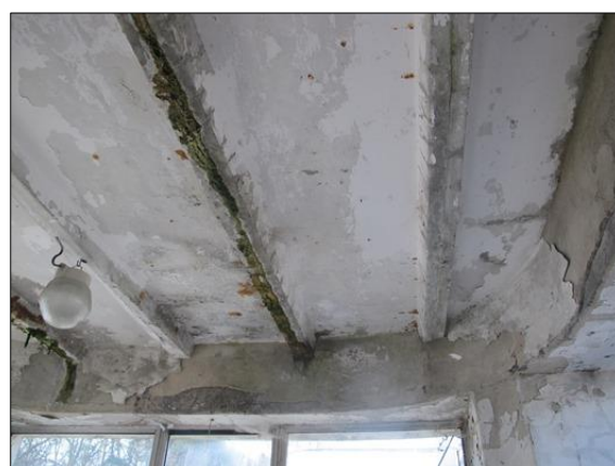
Portiernia – wnętrze budynku
