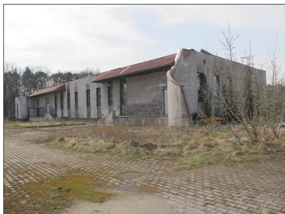
Budynek produkcyjny – elewacja boczna i tylna
